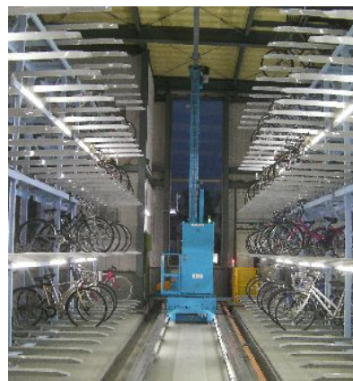
写真 1：弁天橋駅駐輪場
